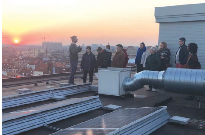
Plus de cent panneaux photovoltaïques ont été installés sur le toit du logement social
